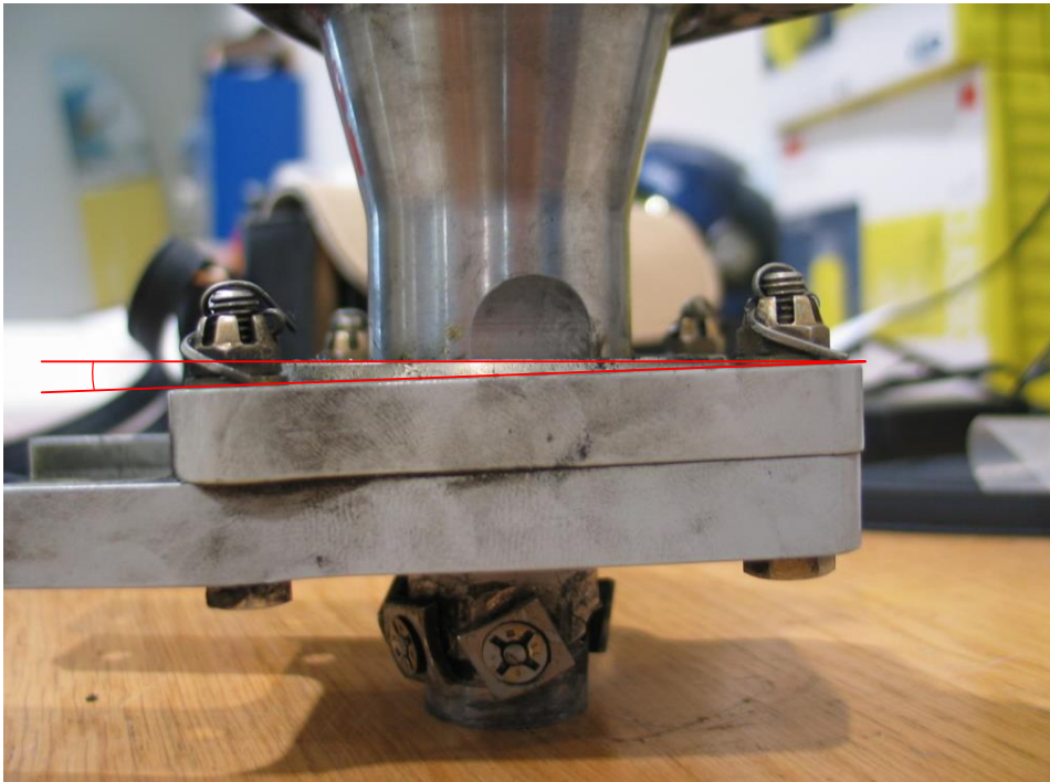
Figur 7: Lager nr. 1, innfestet mellom Bearing Drive og Bearing Flange. Skjevhet markert med røde linjer. Foto: SHT
