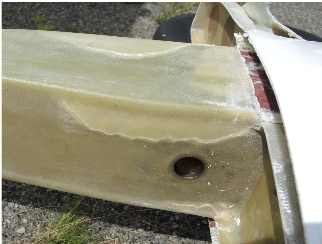
Figur 5: Sprekker og delamineringer i vingebjelkens endestykke. Foto: SHT
