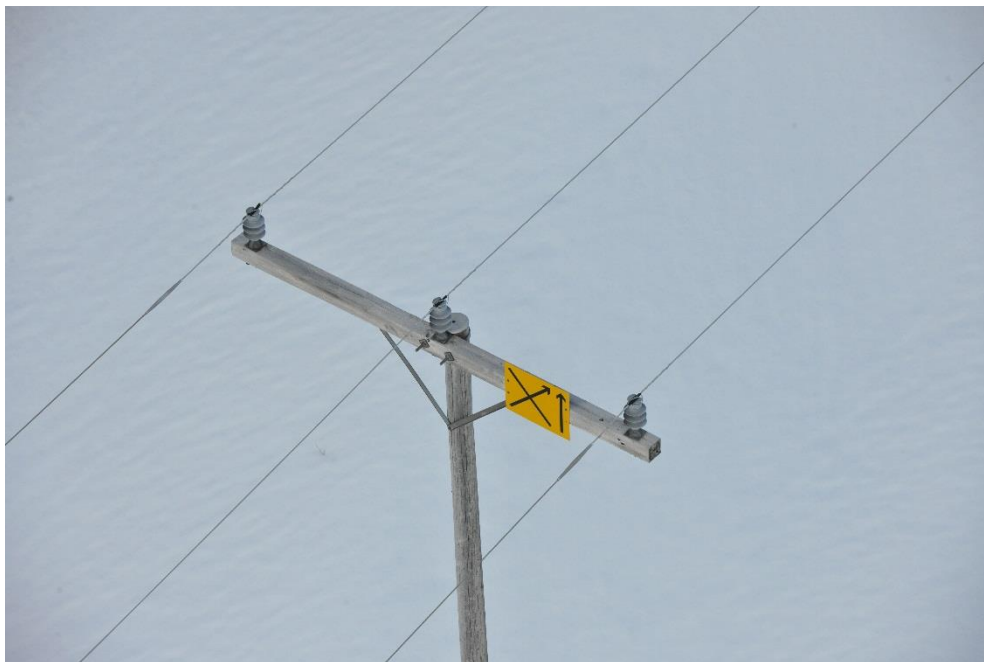
Figur 6: Skilt på kraftlinjenettet til Helgeland kraft som varsler at det kommer en kryssende linje forut. Foto: Pegasus AS
