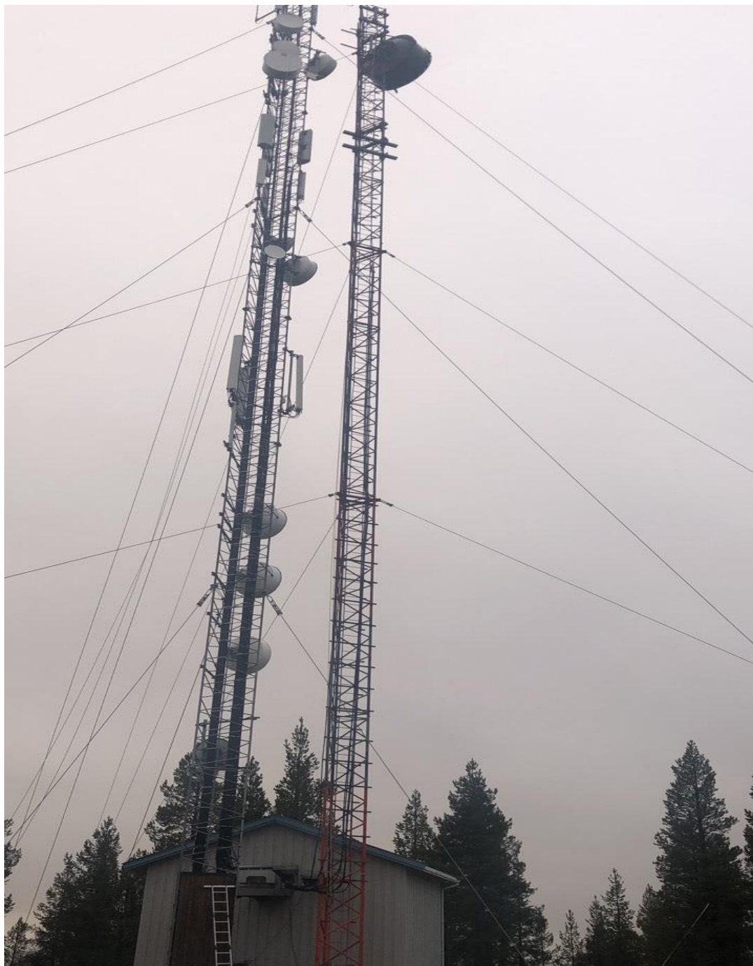
Figur 3: Masten til høyre på bildet klargjort for demontering, og den nye masten til venstre samt Telenor sin hytte. Foto: Heli-Team AS
