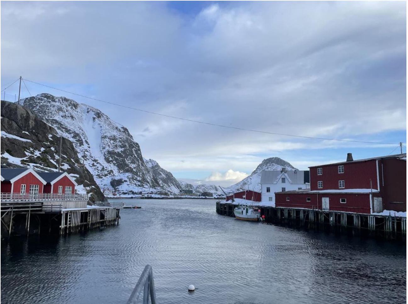
Figur 2: Bilde tatt fra vest, hvor man kan se den nye strømledningen (som er av en annen type enn ledningen som ble kuttet) gå i en hellende vinkel fra Mortsund (til venstre) til Mortsundholmen. Bildet er tatt den 24. februar 2022. Foto: Elmea AS/SHK
