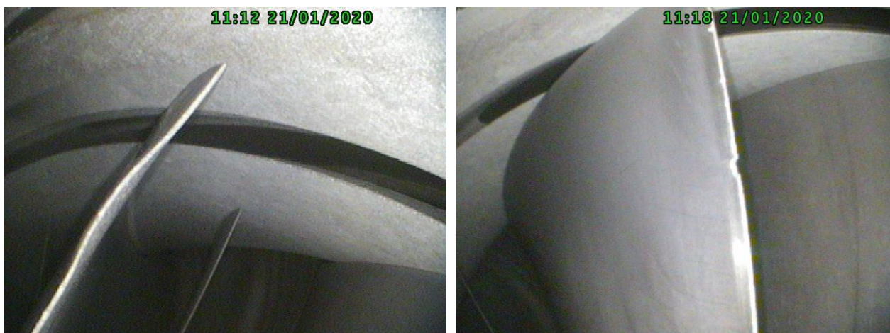
Figur 5: Bilder fra boroskop som viser skader på kompressorblader etter is som løsnet i motorinntaket og ble sugd inn i motoren. Foto: Widerøe
