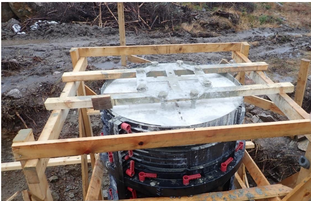
Figur 2: Mastepunkt 49, dagen etter uhellet. Fundamentet var da støpt ferdig. Foto: SHK
