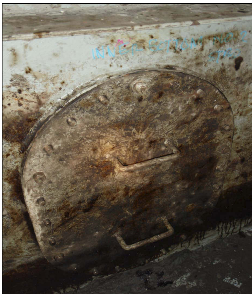
Figur 16: Mannlokk til "void".
