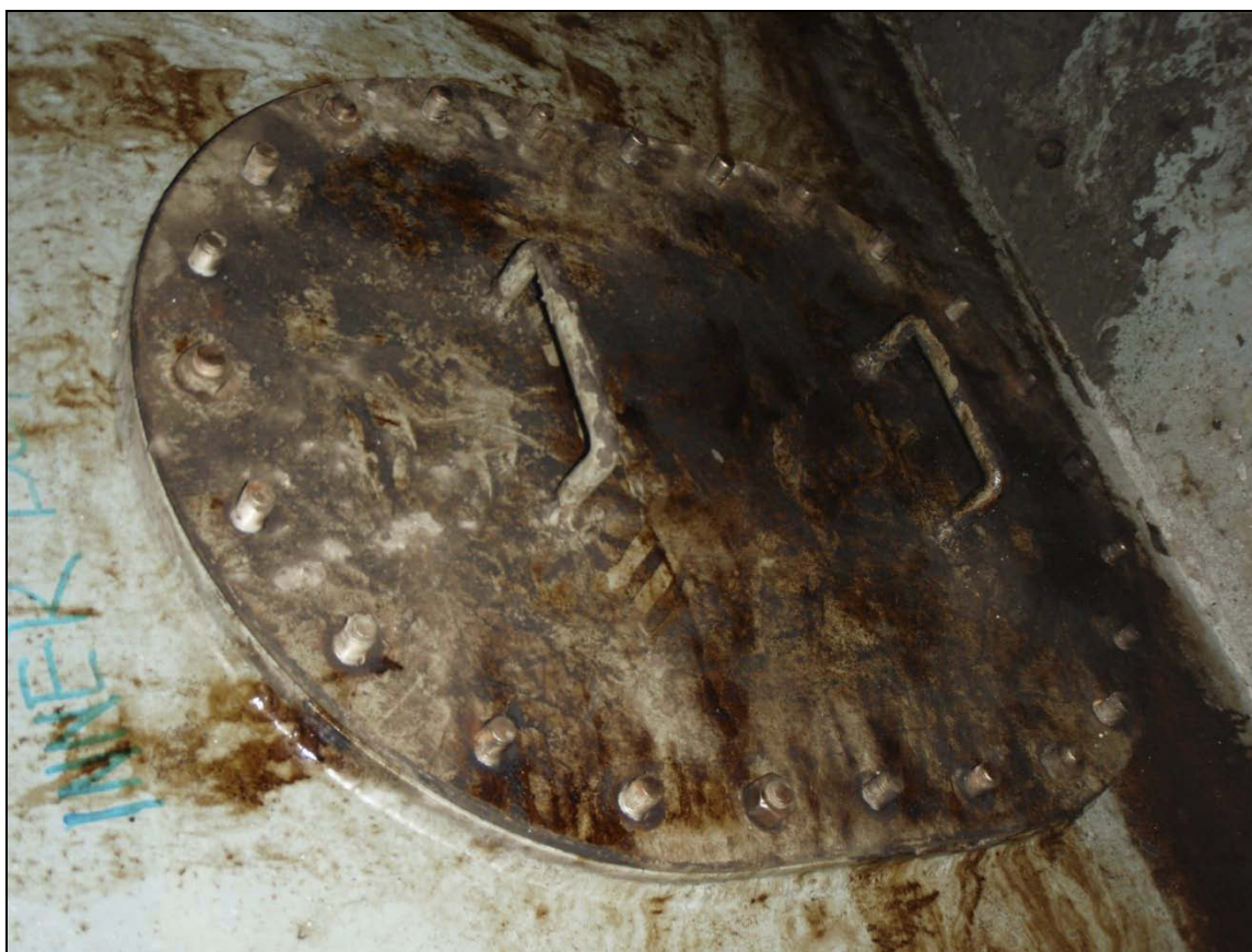
Figur 4: Mannlokk fra lossetanktunnelen til rom under lasterom ("void").
