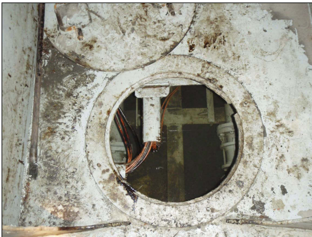
Figur 10: Luke mellom lossetanktunnel og rørtrunk.
