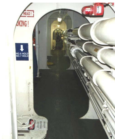
Figur 9: Innelukket gangpassasje styrbord side sett aktenfra og forover. Nederst i venstre bildekant vises en nedgangsluke til ett av lasterommene.
