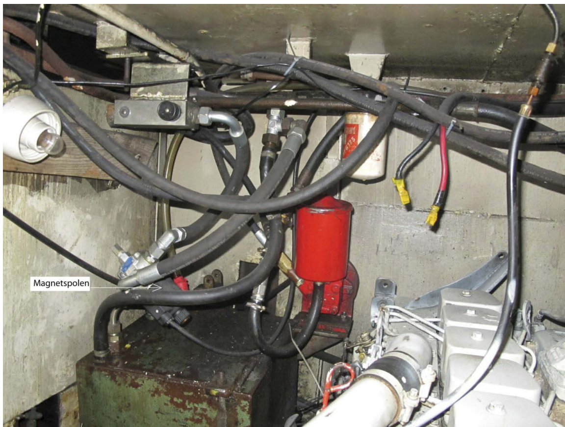
Figur 6: Magnetspolen og hydraulikkpumpa.
