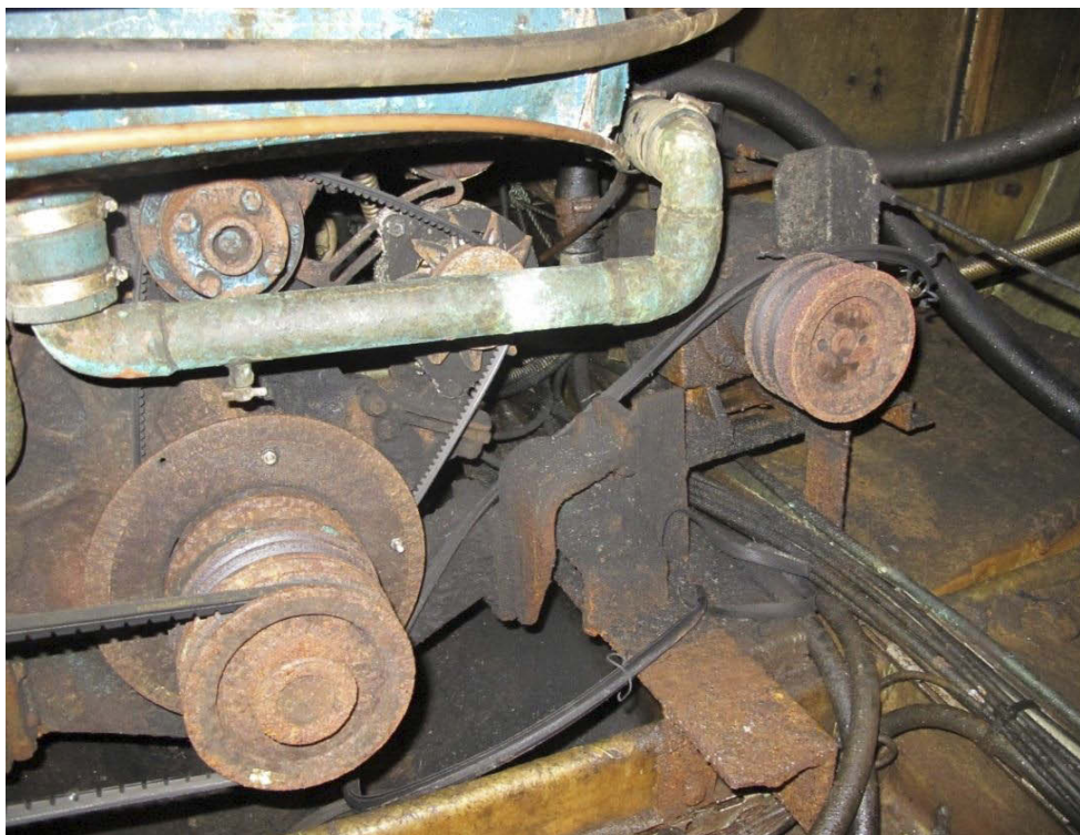
Figur 7: Avslitte kileremmer mellom hovedakselen og hydraulikkpumpa.
