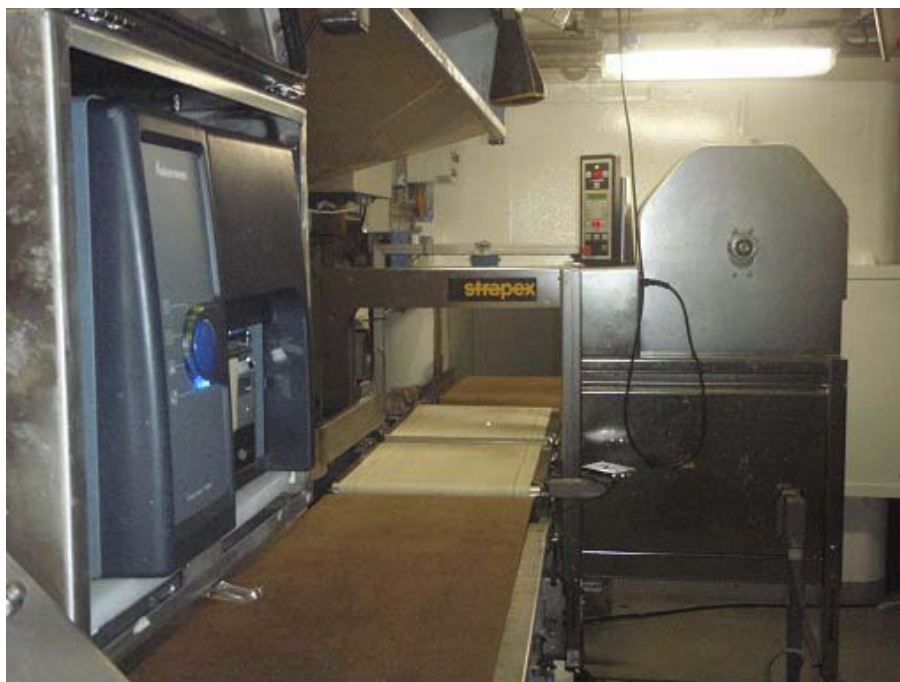
Figur 5: Stroppe-maskin av merke STRAPEX er en frittstående enhet levert fra underleverandør.
