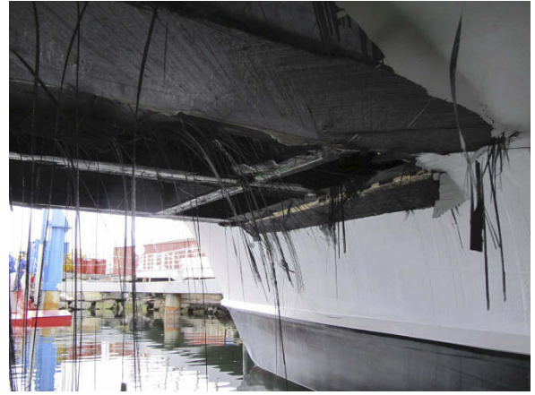
Figur 6: Bildet viser at et ca. 25 m 2 areal av våtdekket bak skråpanelet er revet av.
