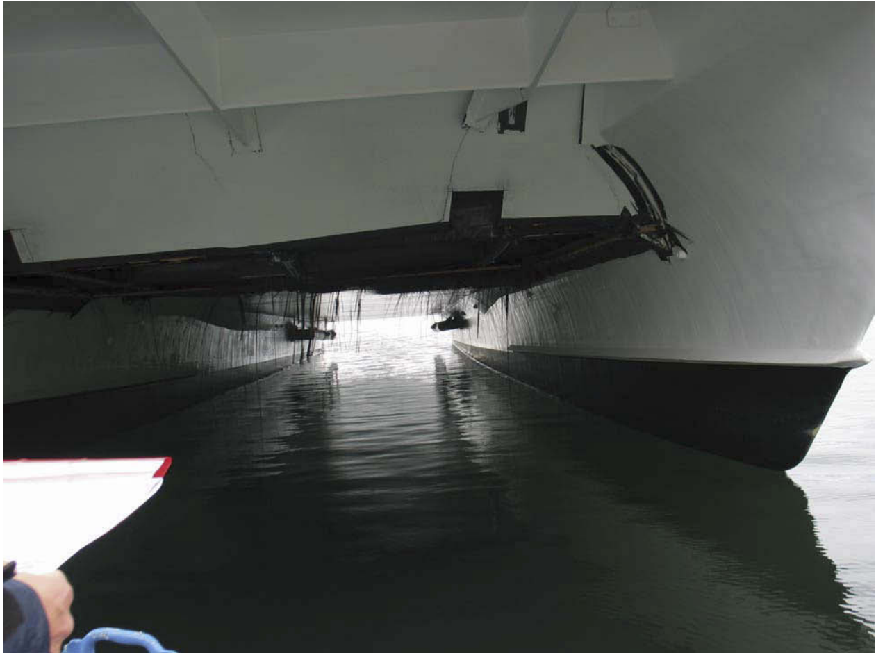
Figur 6.2 Skråpanel mellom våtdekk og bakkdekk. Overflatene viser ingen tegn til kontaktskade med en fast gjenstand.
