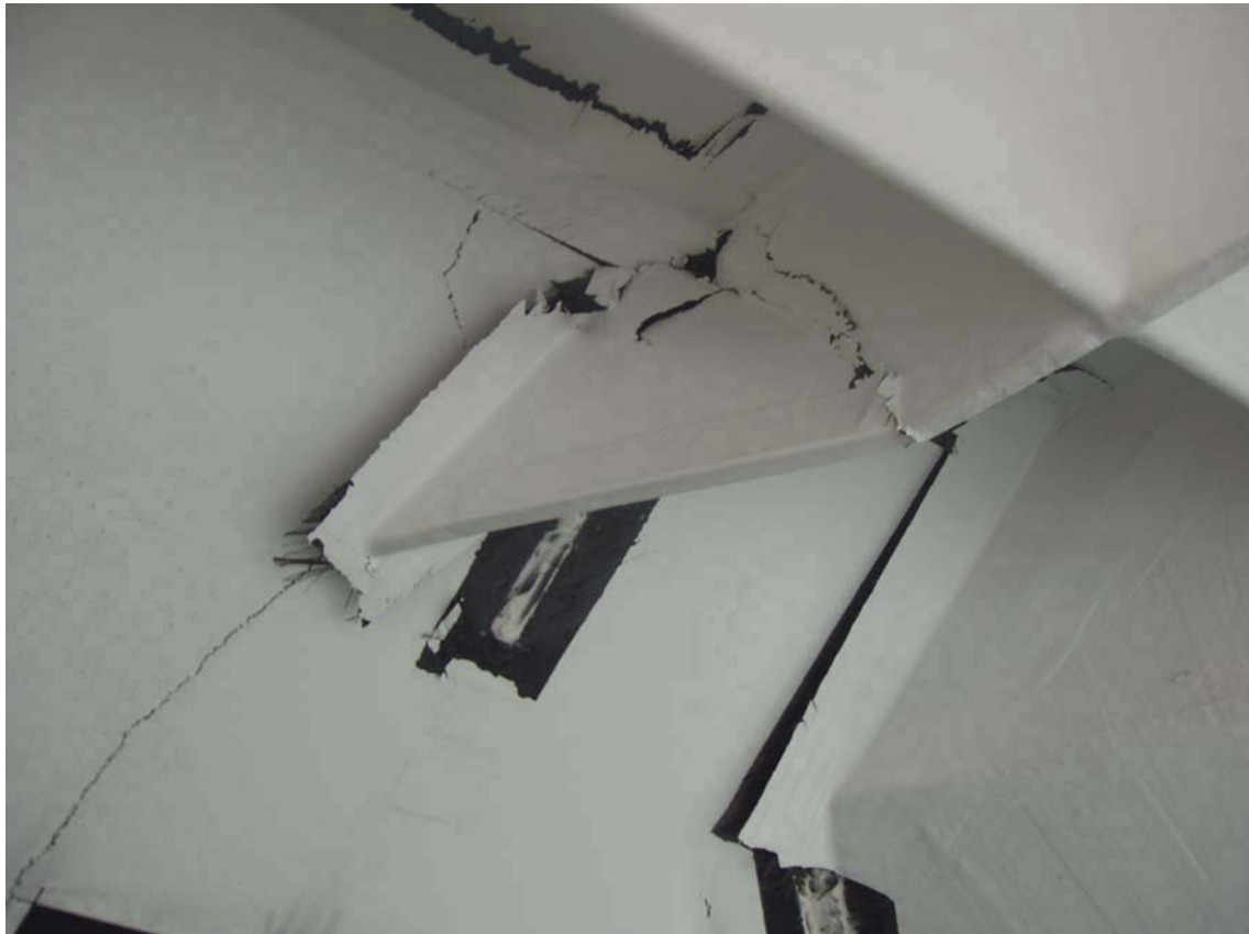
Figur 6.18 Detalj av langsgående bjelke slått til siden.
