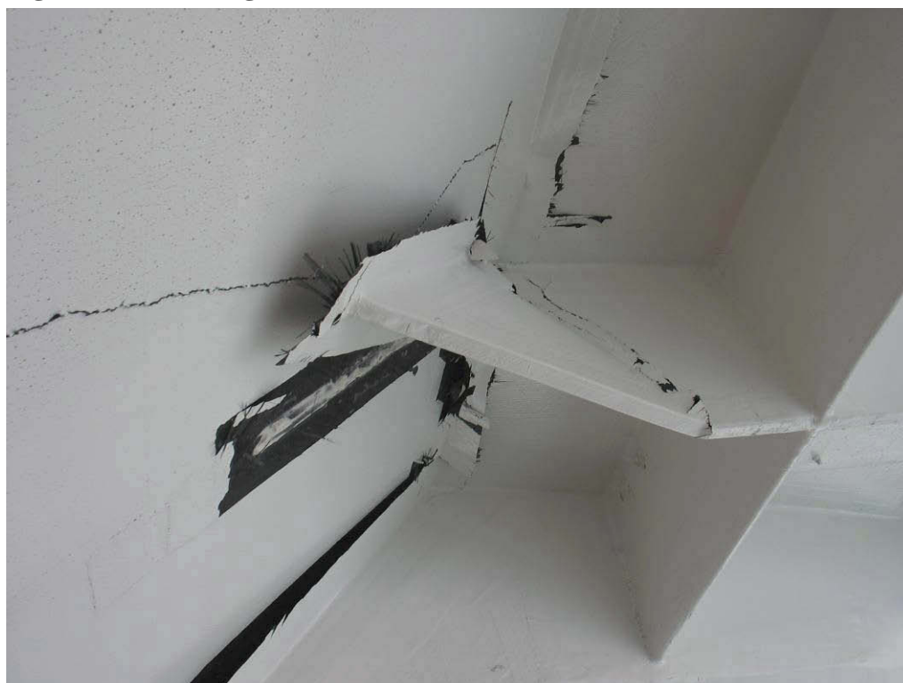
Figur 4.18 Bjelke avrevet fra skråplate og knekt
