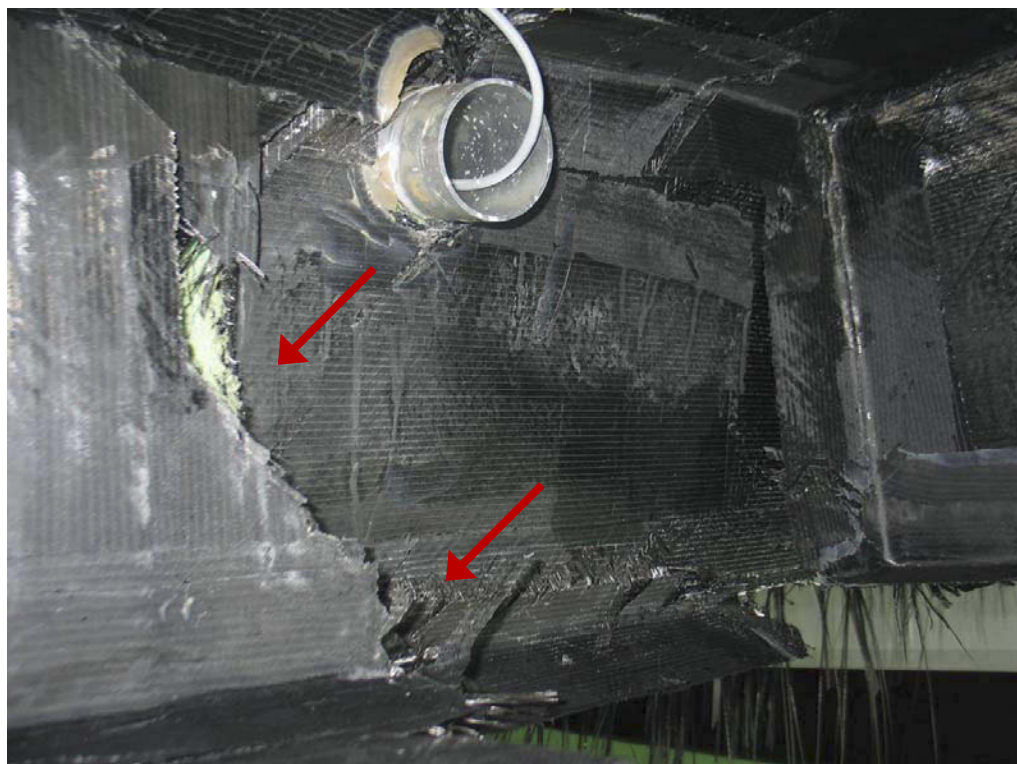
Figur 4.33 Tverrgående skott #28 (SB): Brudd i over/-underlaminat og kjerne
