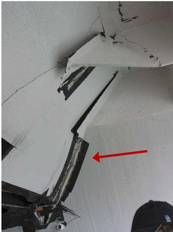
Figur 4.19 Innfesting mot BB skrog løs
