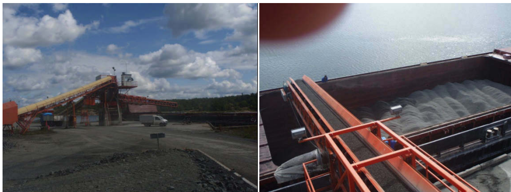
Figur 15: Conveyorbeltet ved lasting i Stårnökrossen.
