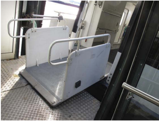
Figur 4: Landgang på styrbord side av akterdekk, sett fra kai. Landgangen hviler på kaidekket. Den svarte klossen på siden er for sikring av landgangen når den står vertikalt. Foto: SHT
