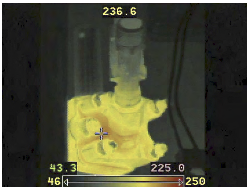
Figur 6 IR-bilde av indikatorkran 3
