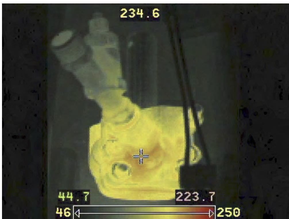
Figur 5 IR-bilde av indikatorkran 3
