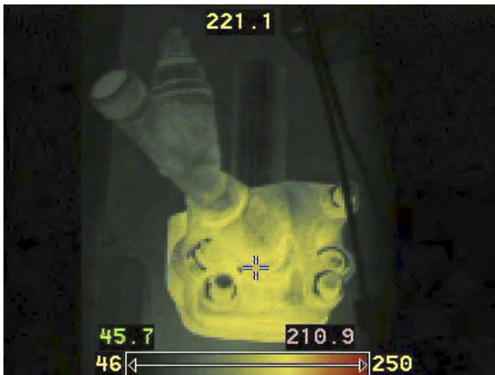
Figur 2 IR-bilde av indikatorkran 1
