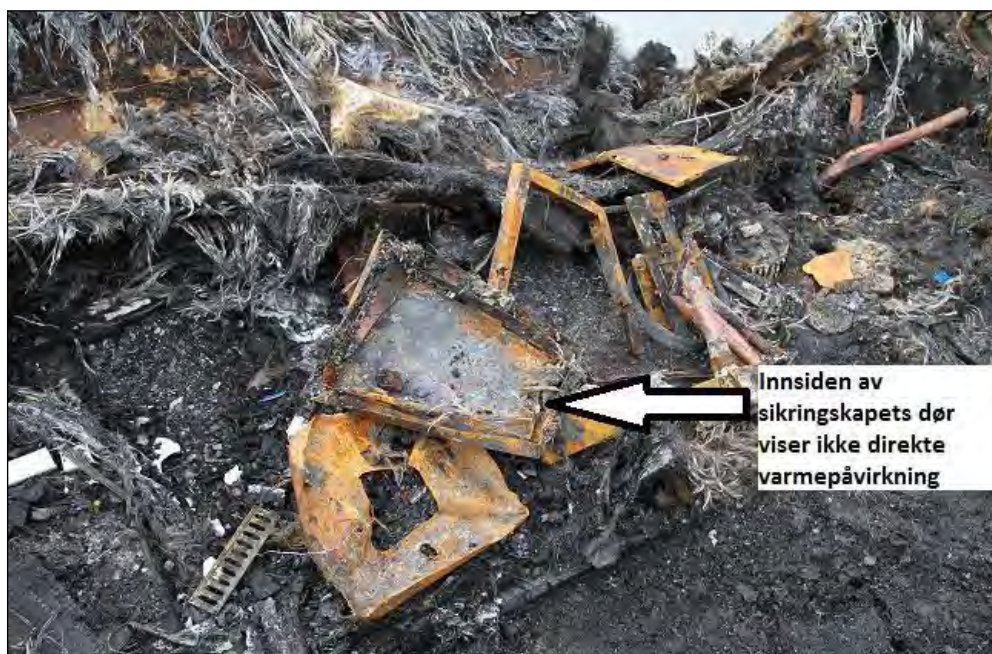
Figur 14: Sikringsskap lokalisert ombord etter brannen. Foto: Politiet
