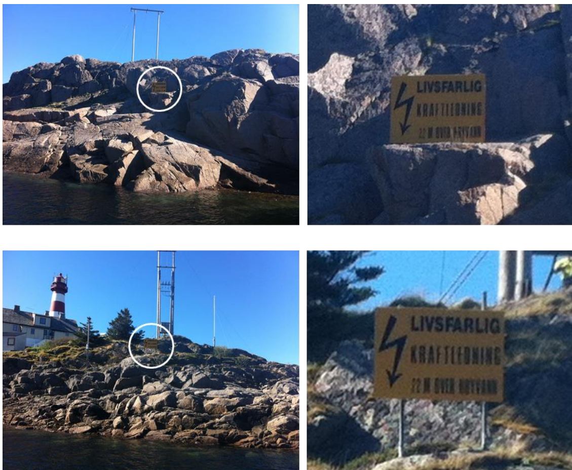
Figur 13: Skilt med informasjon om luftspennet er satt opp ved kabelmastene på begge sider av Fyrsundet. Skiltene plassering er markert med hvit sirkel. Foto: Lofotkraft
