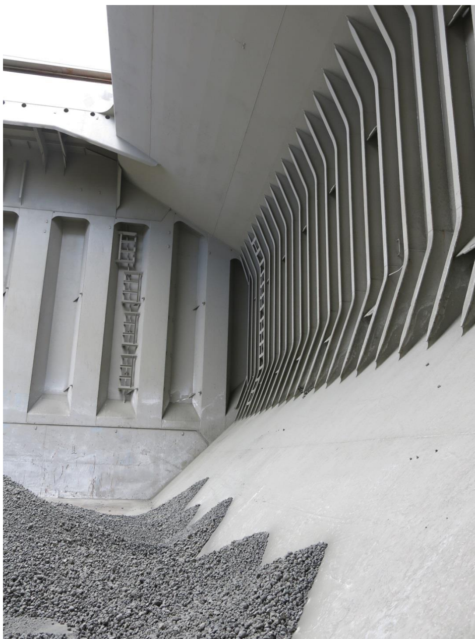
Figur 5: Utforming av lasterom nummer 3, lasten er sementklinker. Foto: SHT
