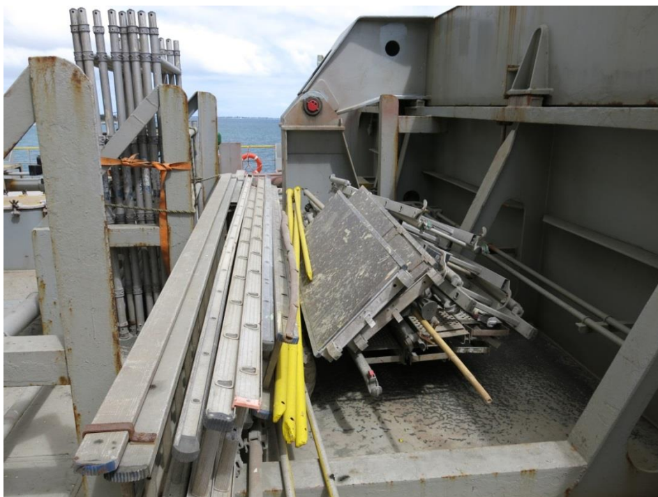
Figur 7: Stiger og stillaser ble lagret i forkant av lasterom nummer 2. Foto: SHT
