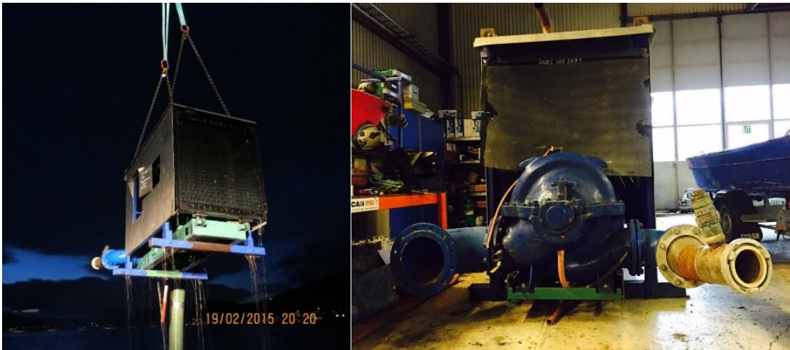
Figur 8: Til venstre spylepumpen sett bakfra med sugeslangen hengende ned. Til høyre pumpen sett forfra med innsuget til venstre og spylekoblingen til høyre. Foto: SHT
