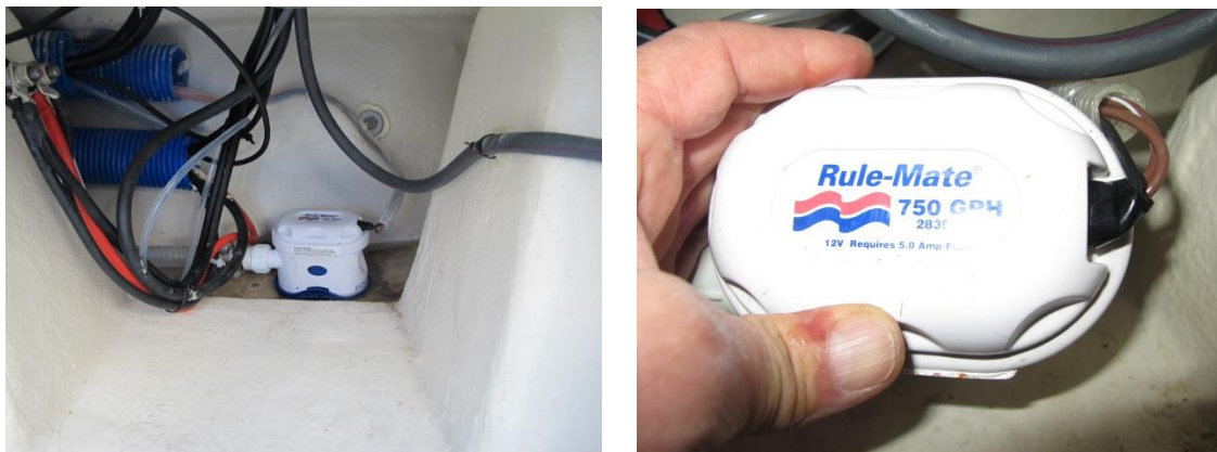
Figur 5: Viking 7 var arrangert med lensepumpe plassert helt akter under dørken. Foto: SHT
