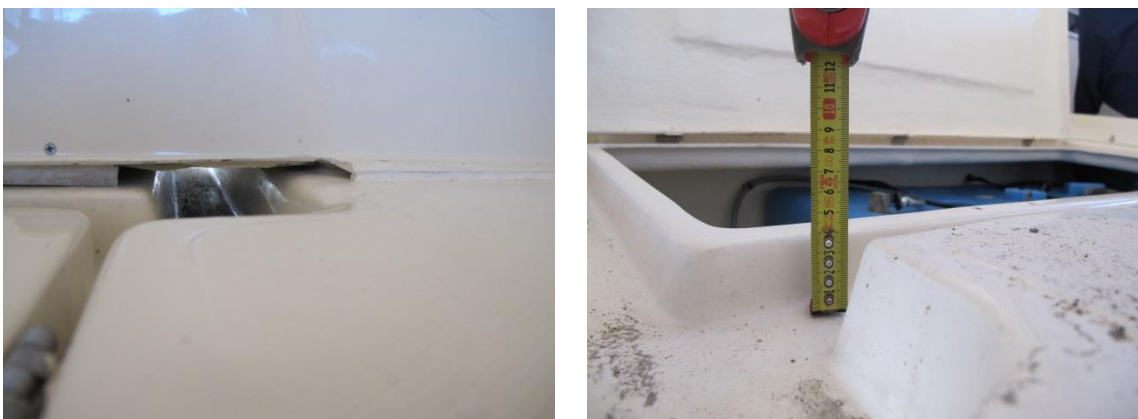
Figur 9: Bildet til venstre viser styrbord dreneringsåpning. Bildet til høyre viser karmen på luken, som hadde en høyde 35 mm over bunnen av dreneringskanalen og 20 mm under dørken. Foto: SHT
