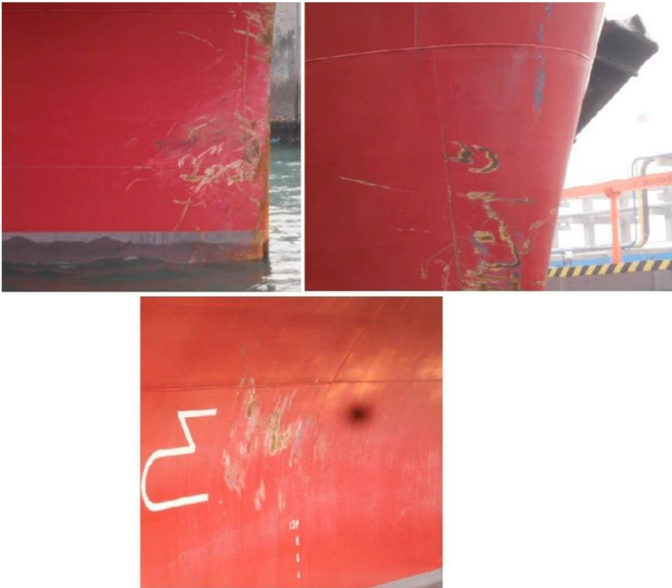
Figur 5: Bildene viser merkene/skadene på Clipper Quitos baug. Foto: Solvang ASA
