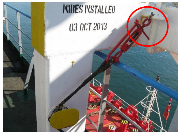
Figur 3: Strekkfiske og sikringen (markert med rød ring) etter at vedlikeholdsjobben var utført. Foto: USCG
