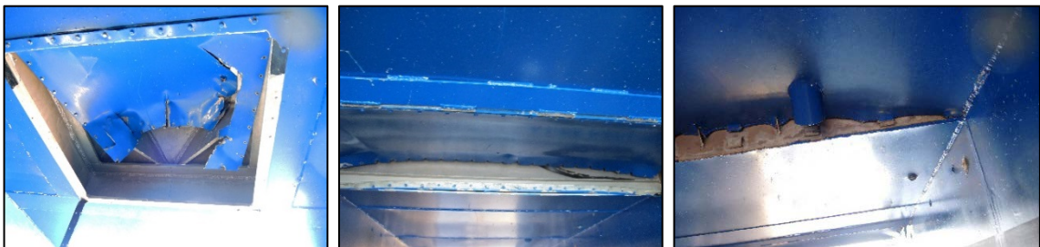
Figur 21: De skadde platefeltene i tunelltakinget. Til venstre i bildet sees den akterste skaden under kranfoten. I midten sees skaden ved eksosrøret og til høyre skaden under badet. Foto: SHT
