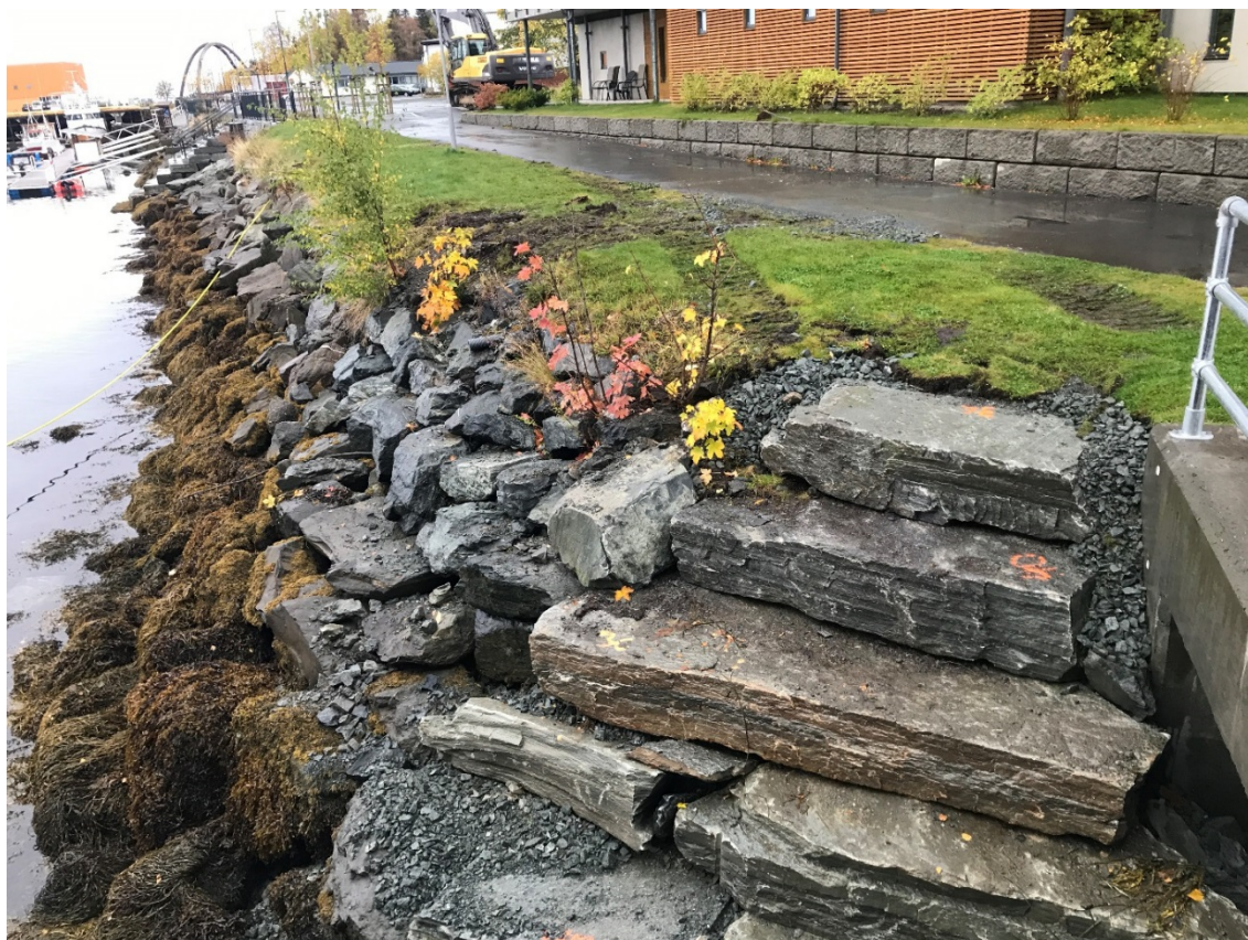
Figur 8: Reparert plastring av steinblokka og deler av rekkverk montert på kaia. Foto: Levanger Kommune
