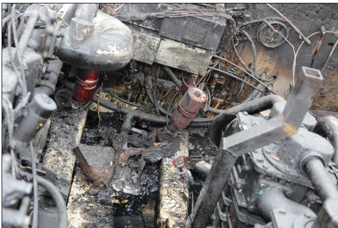
Figur 11: Det automatiske brannslukningsanlegget besto av to Pyrogen/MAG 1, aerosolbeholdere (de to røde) montert i motorrommet på fritidsbåten. Foto: Politiet
