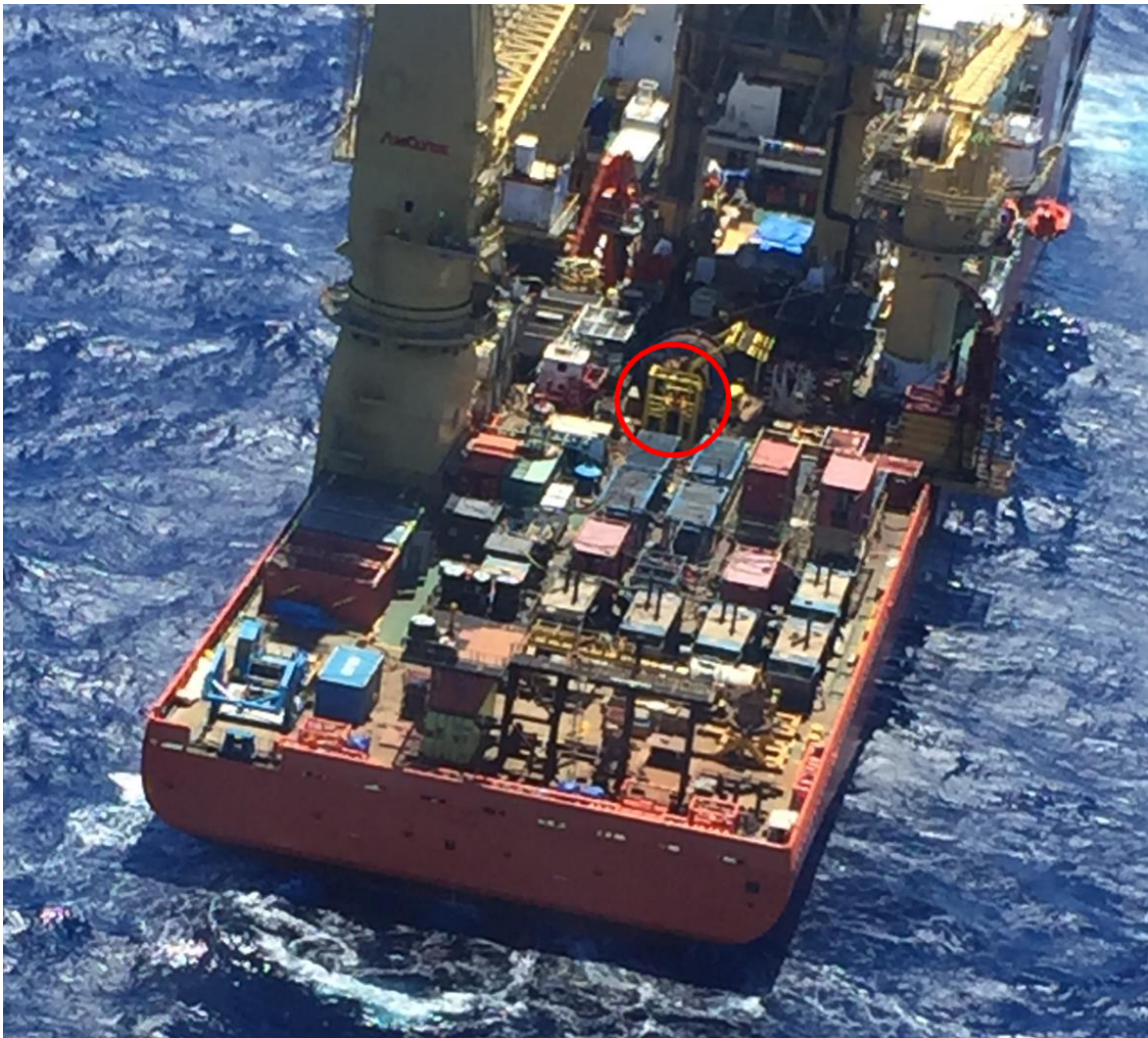
Figur 3: Installasjonen av anlegget for gjennomføring av pre-commissioning oppdraget besto av en rekke komponenter på det utvendige dekket akterut om bord i CSV Normand Maximus. Ulykkesområde er merket med en rød ring. Foto: Brazilian Navy
