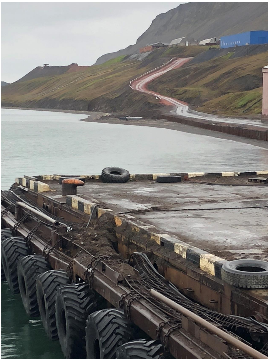
Figur 3: Kai og fenderverk ved den aktuelle kaia i Barentsburg, Svalbard. Foto: SHT
