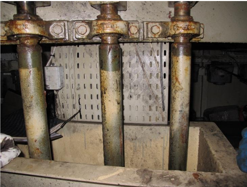
Figur 17: Topp av trunk på brodekk som førte stagene gjennom overbygget ned til maskinrommet. Foto: SHT
