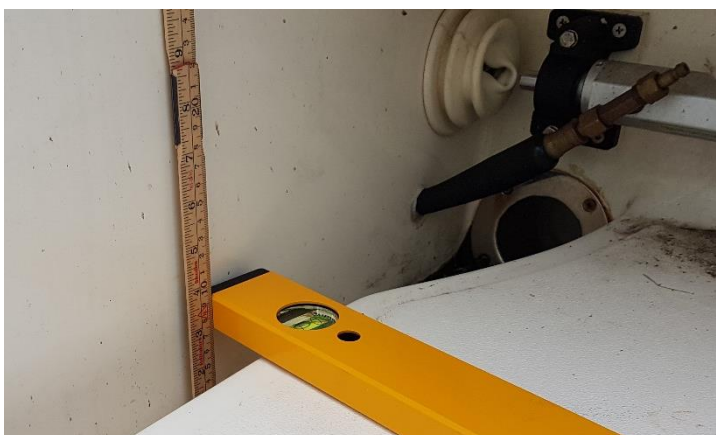
Figur 4: Dreneringskanalane er 71 mm djupe. Foto: SHK
