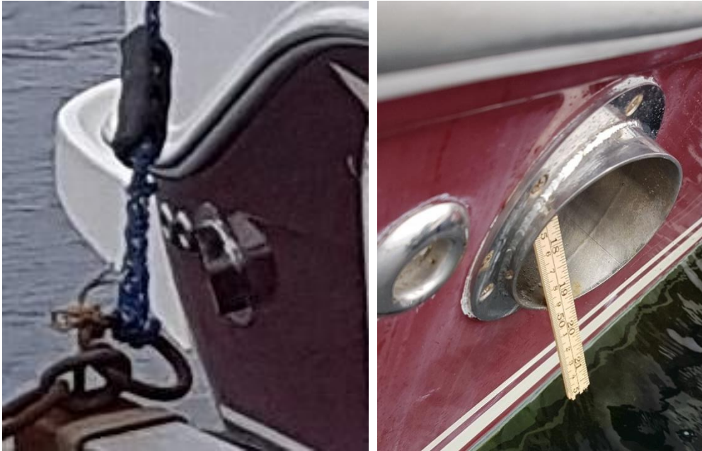
Figur 14: Venstre: Bordgjennomføringer for eksos og kvar av lensepumpene. Høyre: måling av høgda på bend i eksosrøyret. Foto: SHK
