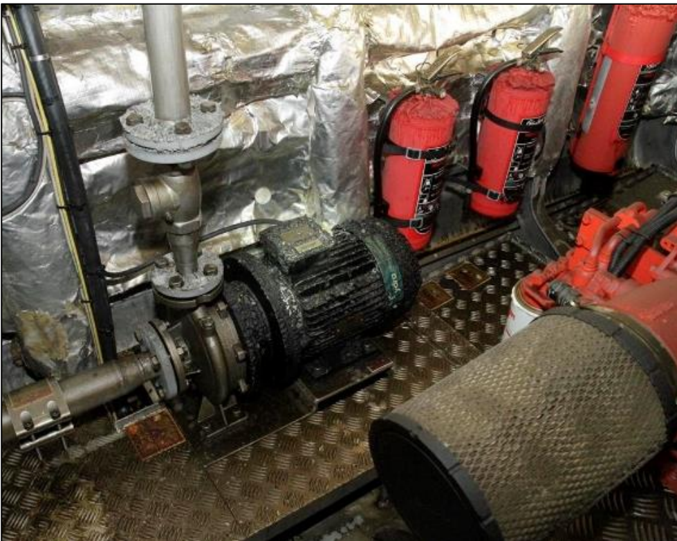
Figur 9: Skader på materiell fra syre og røyk. Foto: Kripos
