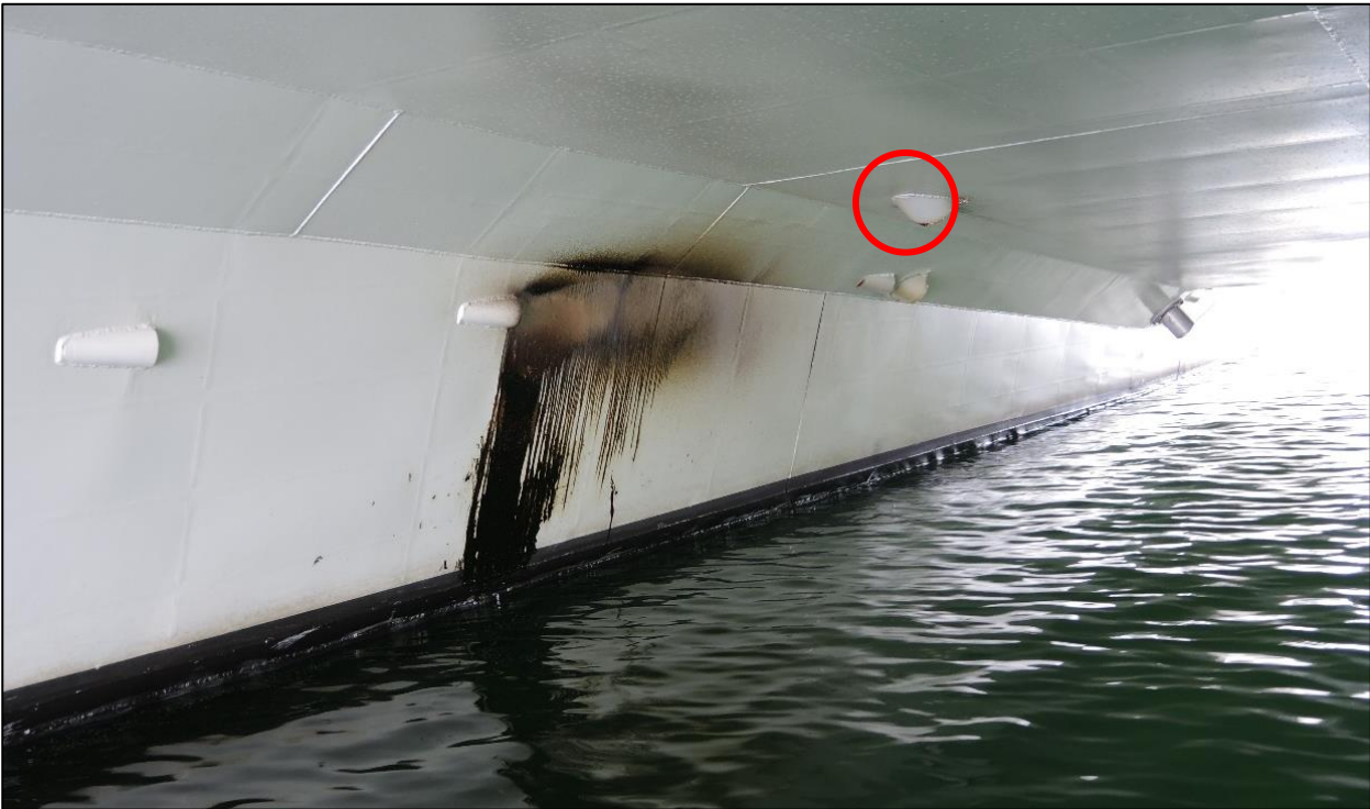
Figur 21: Ventilasjonsutløpet fra batterirommet ut i tunnelen markert med rød sirkel. Sot og brannskade på innsiden av tunnelskroget kommer fra lugar forut for batterirommet. Foto: SHK
