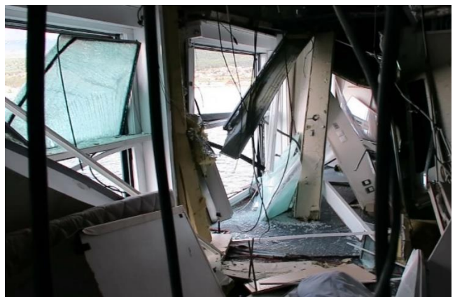
Figur 14: Knuste vinduer i lugar 2016 og 2014. Foto: SHK
