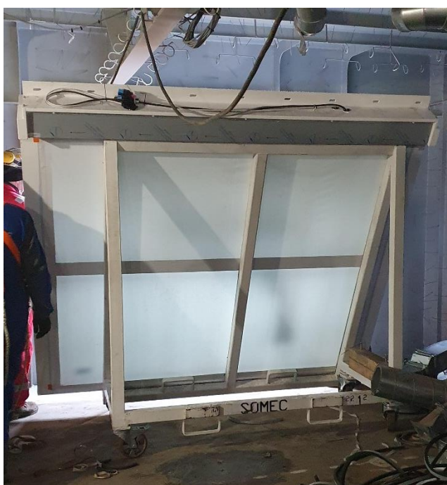
Figur 62: Vinduet klart til montering. Merk boltehullene i overkant av rammen og den horisontale stiveren på midten av vinduet. Foto: Verftet
