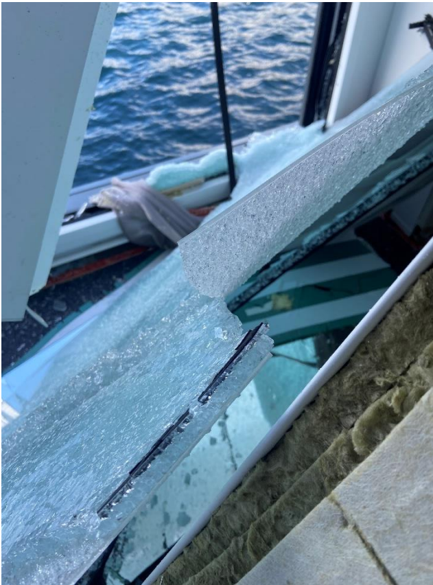
Figur 24: Skade på vindu i lugar 2014. Foto: SHK
