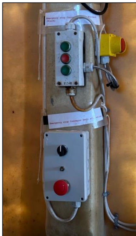
Figur 13: Nødstopp transportbånd. Foto: SHK
