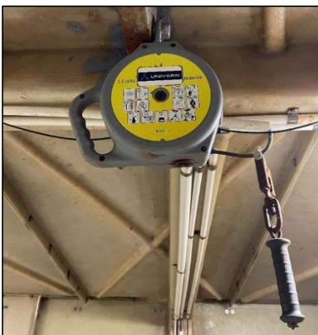
Figur 9: Trommel og håndtak med karabinkrok til sikkerhetsline. Foto: SHK
