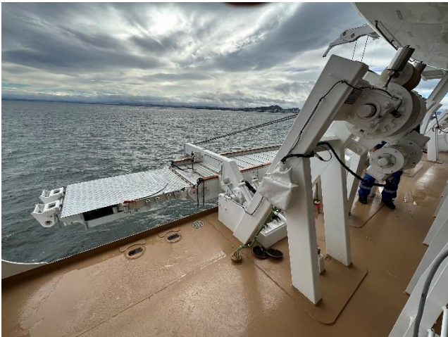
Figur 5: Gangveisystemet vist i forbindelse med en demonstrasjon. Daviten er senket ned i vannrett posisjon fra krybben. Foto: SHK
