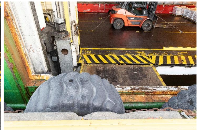
Figur 8: Aktre paleheis og øvre lastedekk sett fra kaikanten. Foto: Politiet
