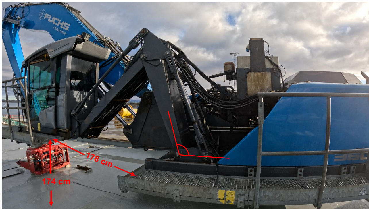
Figur 14: Førerhuset kjørt helt frem. Avstand mellom de to plattformdelene og avstand fra plattform og ned til lukedekk vist i rødt. Foto: SHK
