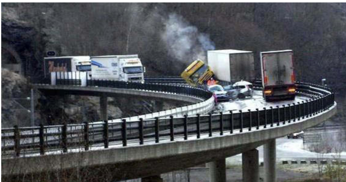
Figur 3: Kjøretøyene der de ble stående på brua etter ulykken. Bildet er tatt ca. 5 min. etter ulykken. Dette bildet viser også hvor det tredje vogntoget i rekken stoppet. (Foto: Bergens Tidende)
