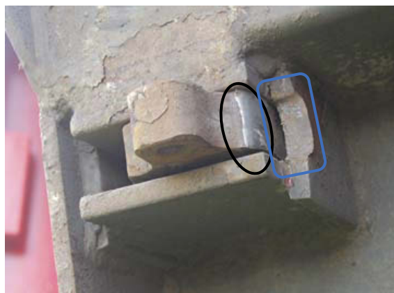
Figur 11: Viser høyre låseanordning fra undersiden. (Foto: Statens vegvesen)
