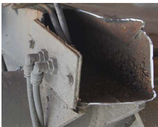
Figur 7: Viser tipprammens bruddflate bak på venstre side. (Foto: Statens vegvesen)
