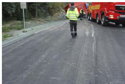
Figur 15: Viser begynnelsen på sporet fra fremre felg på tilhengerens venstre side og krokcontainerens første treffpunkt i veibanen. (Foto: Statens vegvesen)
