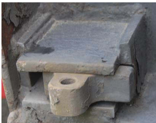
Figur 10: Viser venstre låseanordning fra undersiden. (Foto: Statens vegvesen)
