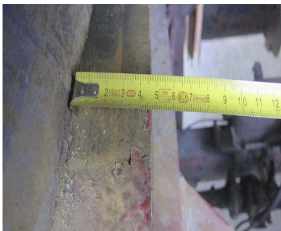
Figur 13: Viser innvendig frihetsgrad på høyre side (i kjøreretningen). Containeren har blå farge og tilhengeren har rød farge. På denne siden har containeren relativt stor mulighet for bevegelse sideveis. Se i sammenheng med Figur 17.
