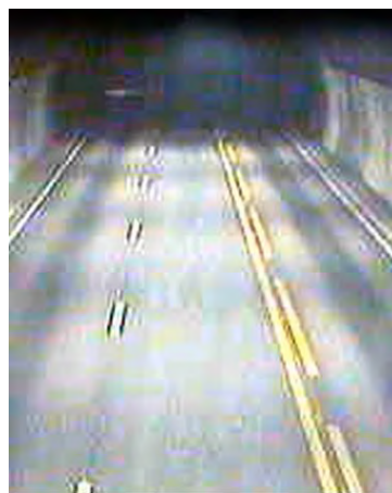
Figur 3: Røyk i tunnelen. Foto: Utklipp fra videoovervåking i tunnelen – Statens vegvesen
