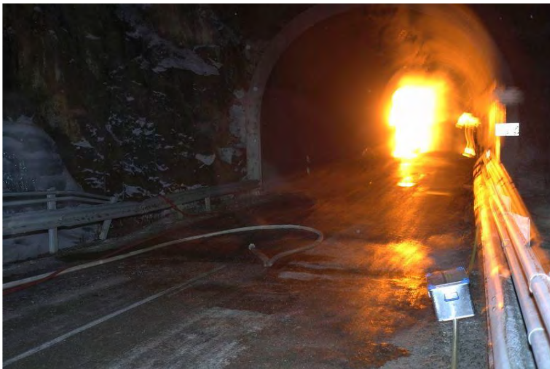
Figur 19: Brann i tilhenger i Brattlitunnelen. Foto: Avisa Nordland – Ann-Cathrin Braseth
