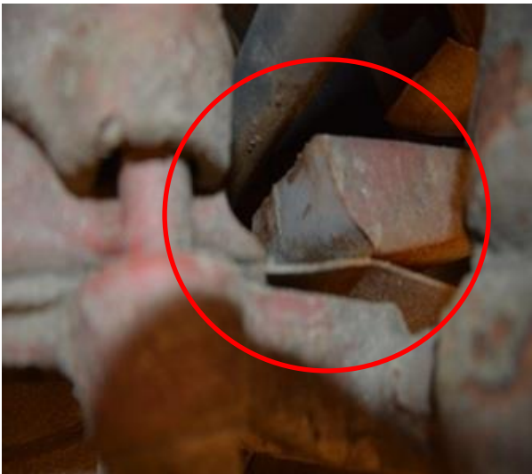
Figur 4: Bruddet i akselens føringsfjær. Foto: Statens vegvesen, ill: SHT
