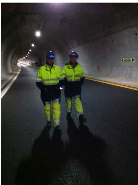
Figur 2: Hendelser i tunneler kan ha et stort skadepotensial - her fra befaring i en ny moderne tunnel på E6. Foto: SHT
