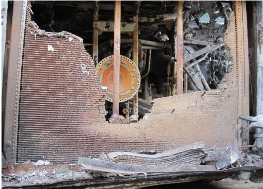
Figur 9: Radiator og viftepumpe (bak rundt skive). Foto: SHT
