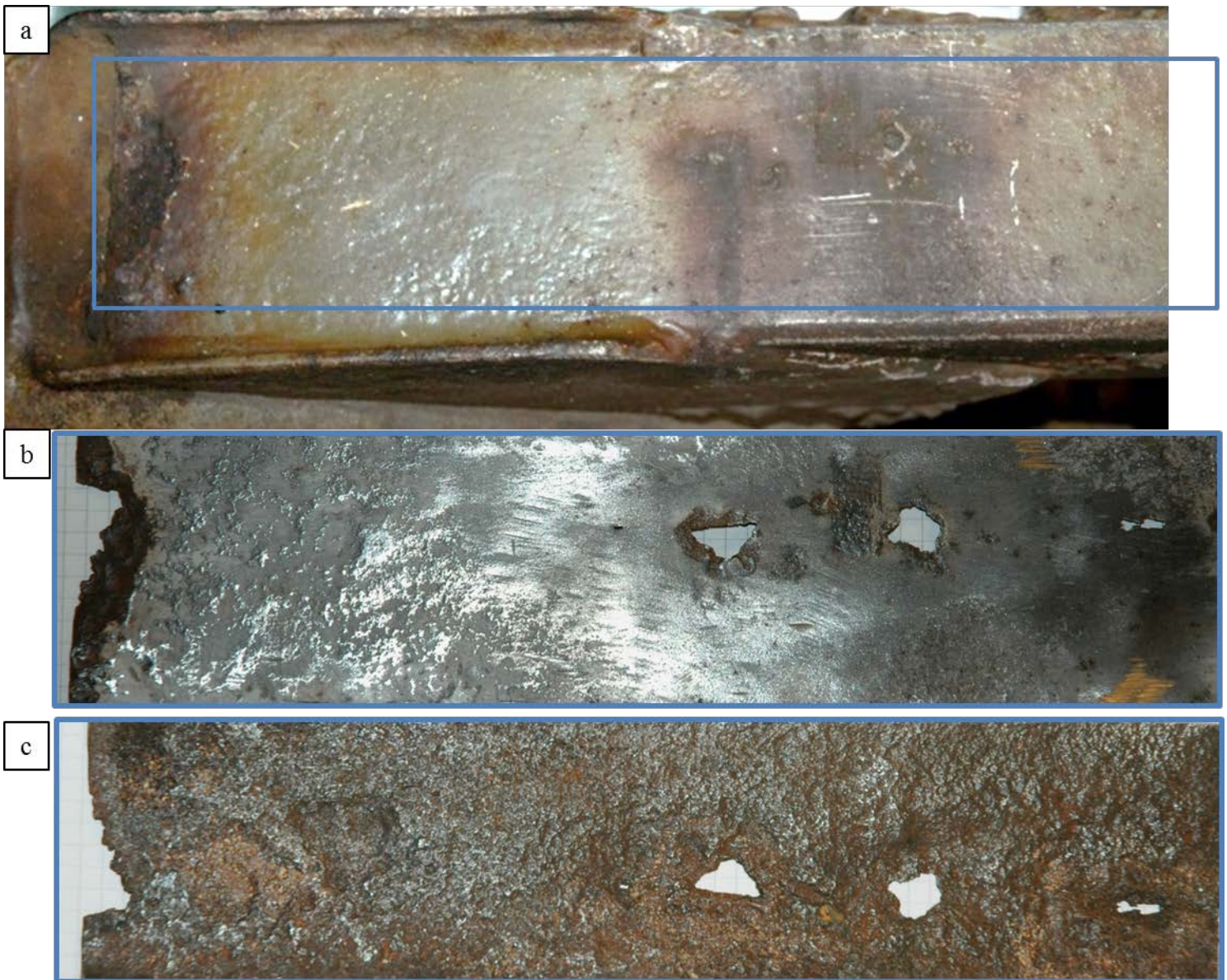
Figur 7a: Bilde av område for prøveuttak for bestemmelse av korrosjonsgrad. b: Bilde av fremside av profil etter fjerning av maling. c: Bilde av innside etter fjerning av overflaterust.
