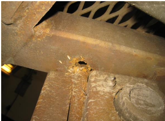
Figur 13: Rustskader i venstre dragstang. Foto: Statens vegvesen
