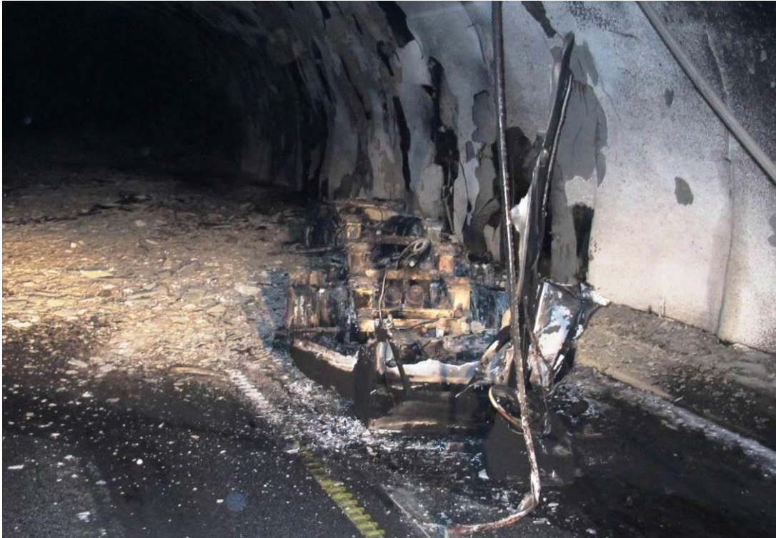
Figur 4: Restene av tanktilhengeren slik den ble stående etter at den hadde løsnet fra bilen. Foto: SHT
