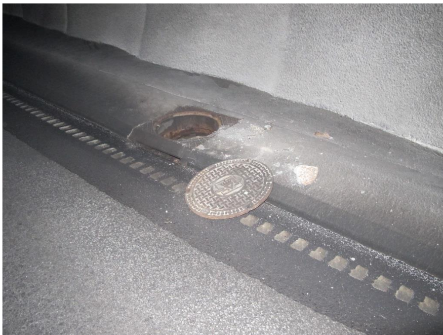
Figur 1 En bild över hur bensinen har runnit på vägbanan från släpet och ner mot pumphuset i botten på tunneln. Den mörka delen på vägbanan är där bensinen har runnit när det började brinna. Locket har en diameter på 0.609 m.
