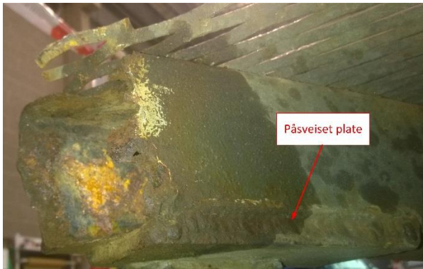
Figur 15: Påsveiset plate på venstre dragstang i forbindelse med rustreparasjon. Foto: SHT
