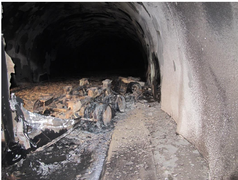
Figur 2 Placeringen av släpet efter branden. Notera placeringen av främre hjulparet mot tunnelväggen.
