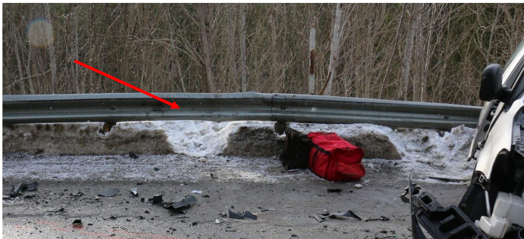
Figur 12: Synlige deformasjoner, skrapemerker og merker i snø. Foto: Politiet
