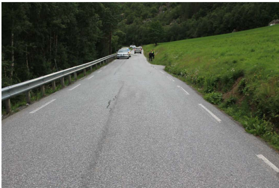
Figur 8: Sørgående kjørefelt sett fra bussførerens posisjon. Det er en innsnevring på veien på ca. 0,7 meter på stedet. Foto: Statens vegvesen
