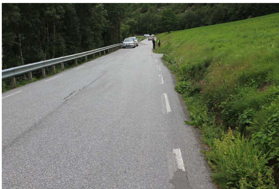
Figur 9: Veien blir smalere etter adkomsten til jordbruksarealet. Foto: Statens vegvesen.
