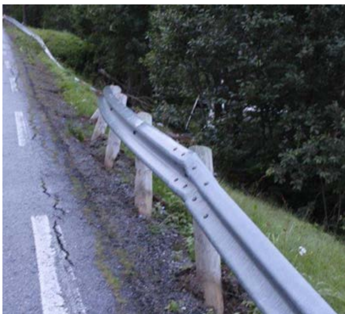
Figur 13: Rekkverket ble bøyd ned og trestolper løsnet fra festet da bussen veltet. Foto: Statens vegvesen
