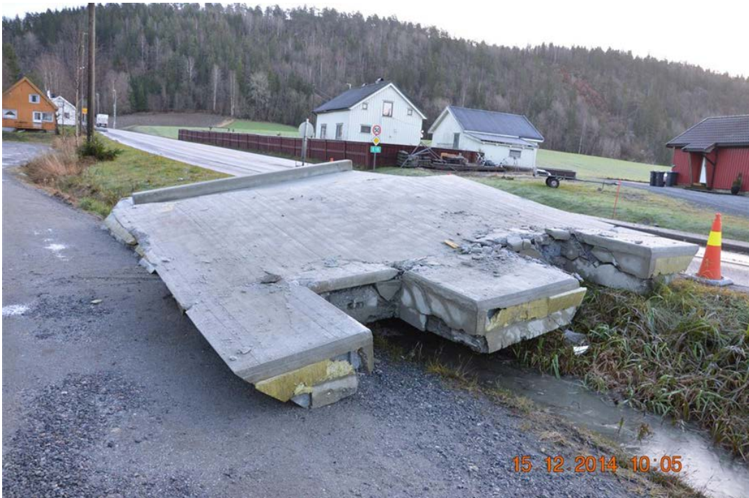
Figur 15: Skader på et av elementene som ble transportert. Toppen av elementet vises i framkant av bildet. Foto: Statens vegvesen
