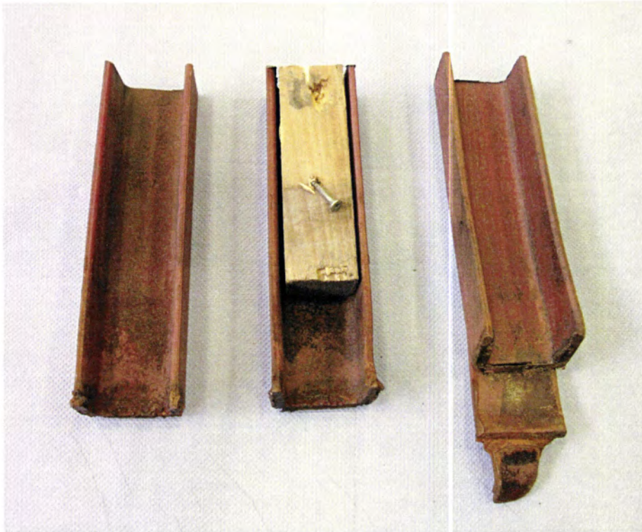
Foto 3. Nedre delen på tre av stödbenen. Svetsarna framgår i bildens nederkant. Observera att det högra benet tidigare har utsatts för någon form av enkel reparation.
