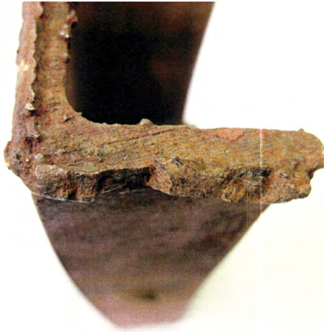
Foto 5. Dålig inbränning, a-mått otillräckligt.
