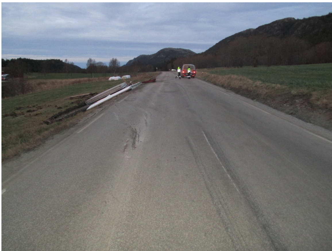
Figur 7: Spor/merker avsatt i kjørebanelen da vogntoget veltet. Foto: Statens vegvesen
