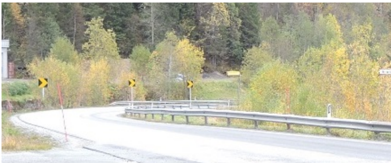
Figur 17: Sebraskilt i kurven, med sammenleggbart skilt nr. 116 i forkant av kurven, utført av Statens vegvesen. Foto: SHT
