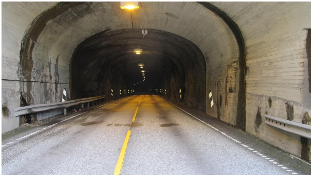
Figur 8: Bildet er tatt fra tunnelåpning i personbilens kjøreretning. Foto: SHT
