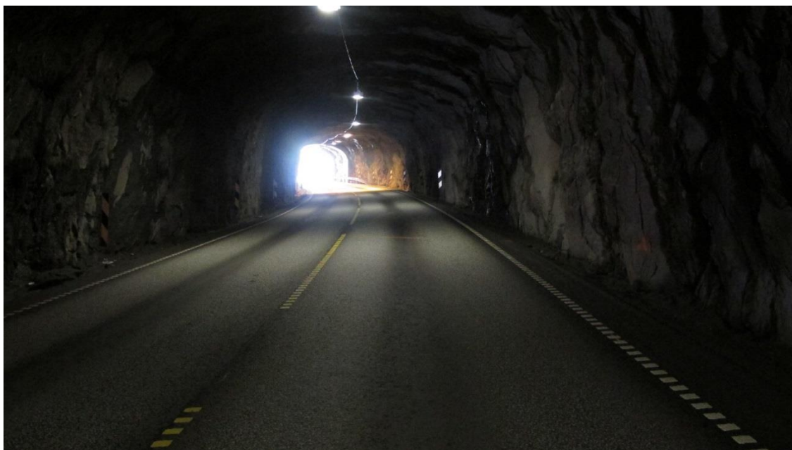
Figur 9: Vegmiljø inne i Raunekleivtunnelen. Foto: SHT
